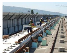
F : レール敷設
