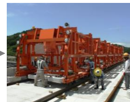
D : 軌道スラブ敷設
