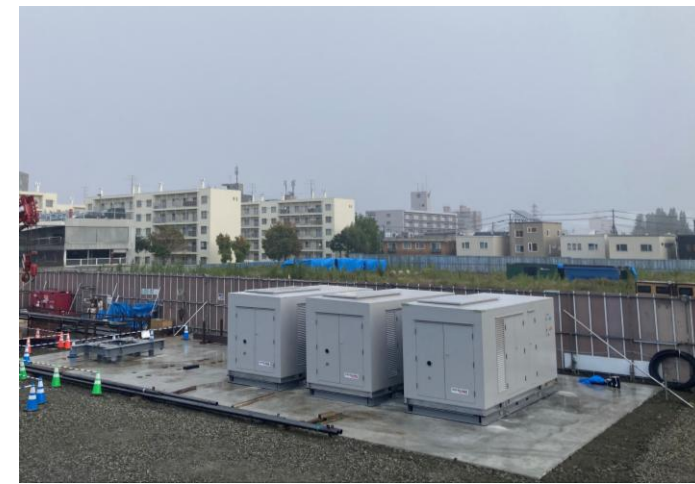
凍結設備設置の様子
