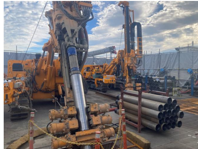
凍結管埋設の様子
