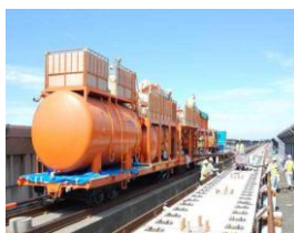
E : CAモルタル注入
