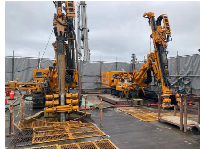
凍結管埋設の様子
