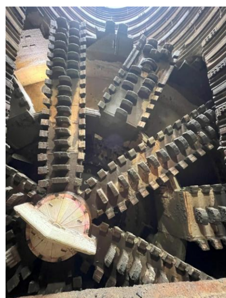
ビット交換作業完了
