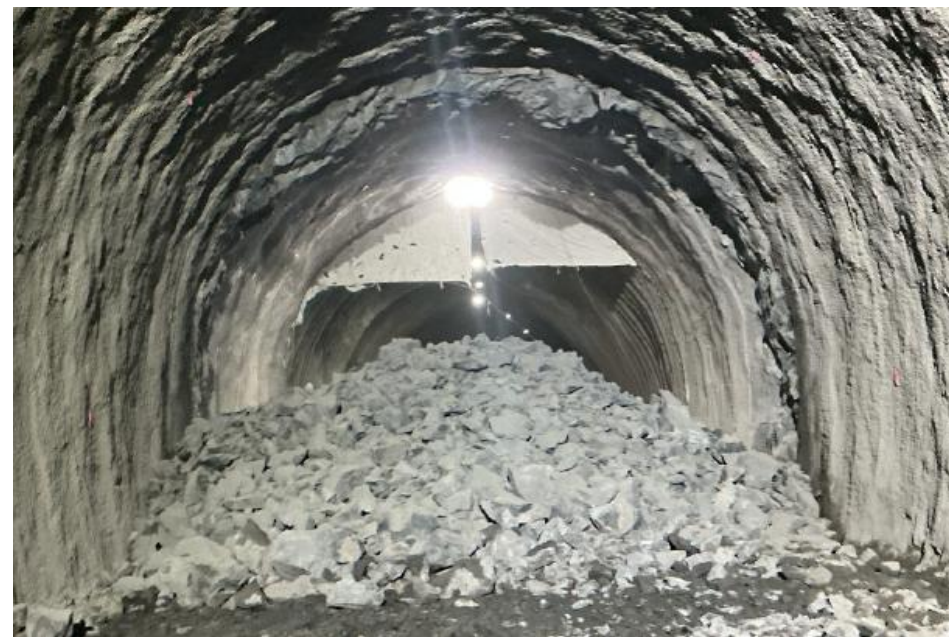
掘削完了地点の状況
