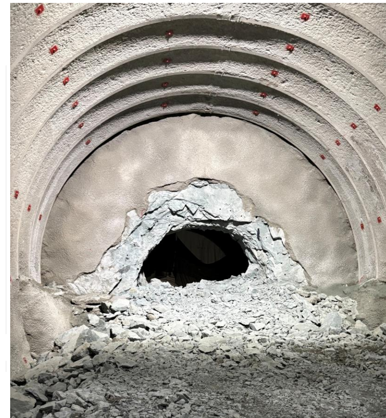
掘削完了地点の状況
