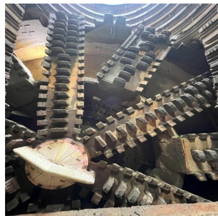
ビット交換作業完了
