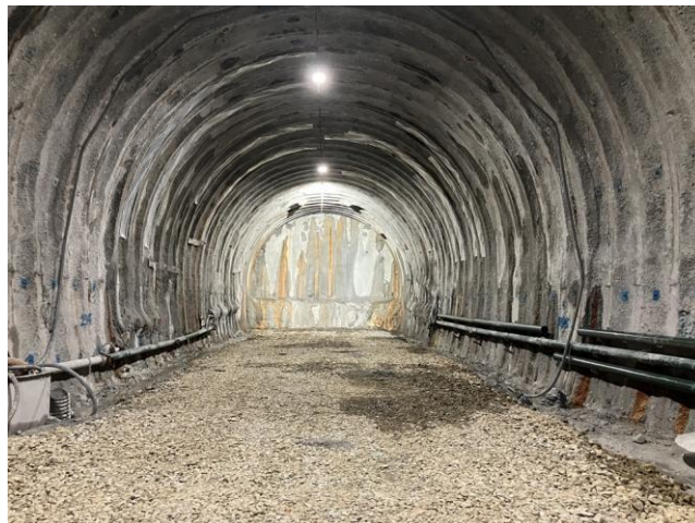
札幌トンネル(銭函) 湧水処理状況 (新函館北斗方を望む)
