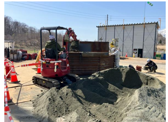
中間立坑埋戻し作業
