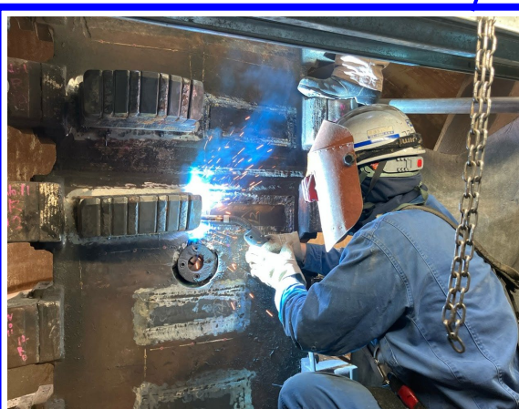
ビット交換状況
