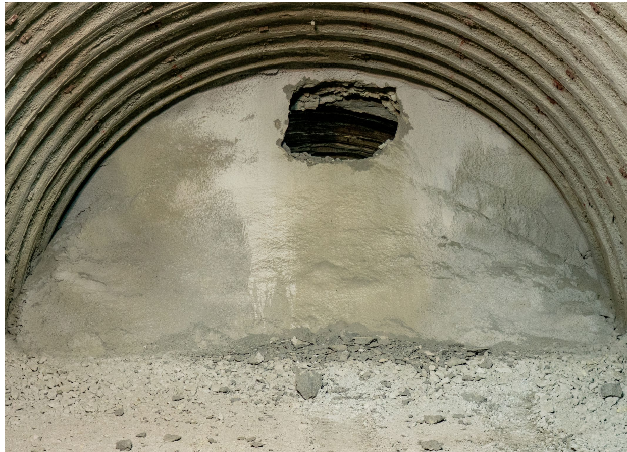
掘削完了地点の状況
