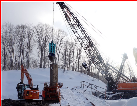
岩塊撤去状況
