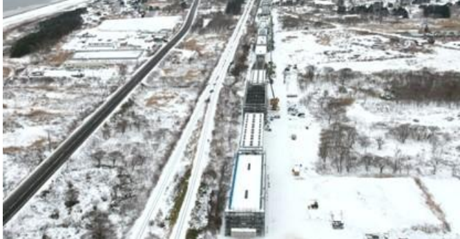
写真⑫ 平里高架橋(長万部町)
