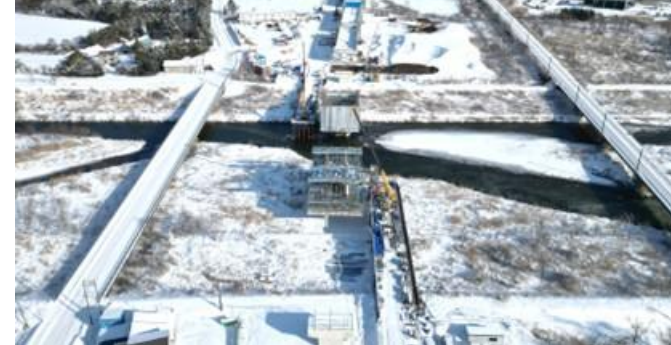
写真⑪ 榮原高架橋(長万部町)
