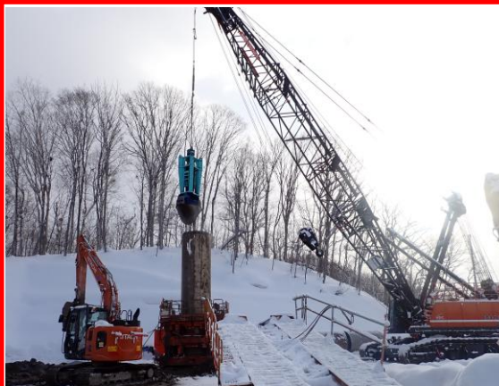
岩塊撤去状況
