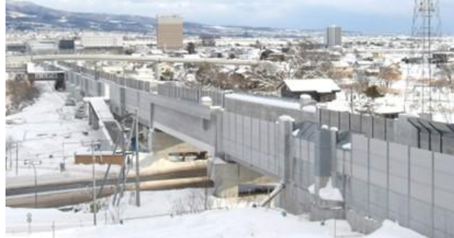
写真⑯ 市渡高架橋(北斗市)
