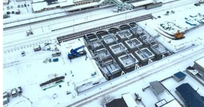
写真⑬ 長万部駅高架橋(長万部町)
