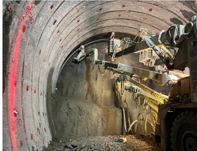
札幌トンネル(富丘) トンネル支保工の建込施工状況
