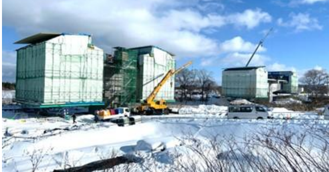
写真⑮ 大新高架橋(八雲町)
