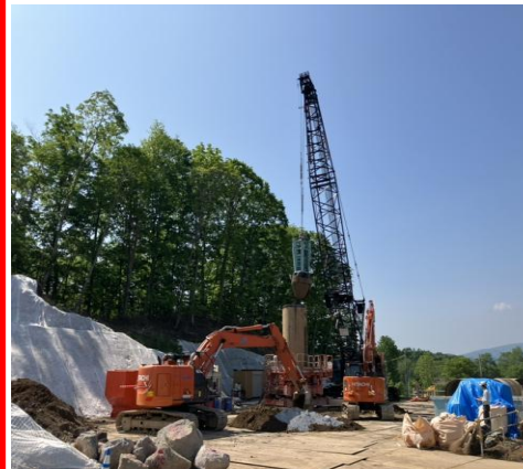
岩塊撤去状況
