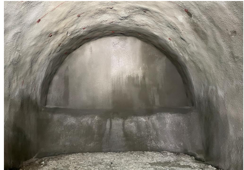
掘削完了地点の状況
