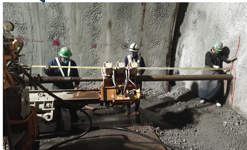
水平ボーリング実施状況
