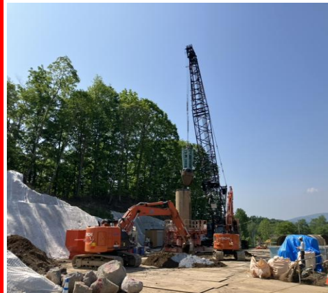
岩塊撤去状況
