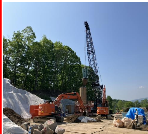
岩塊撤去状況
