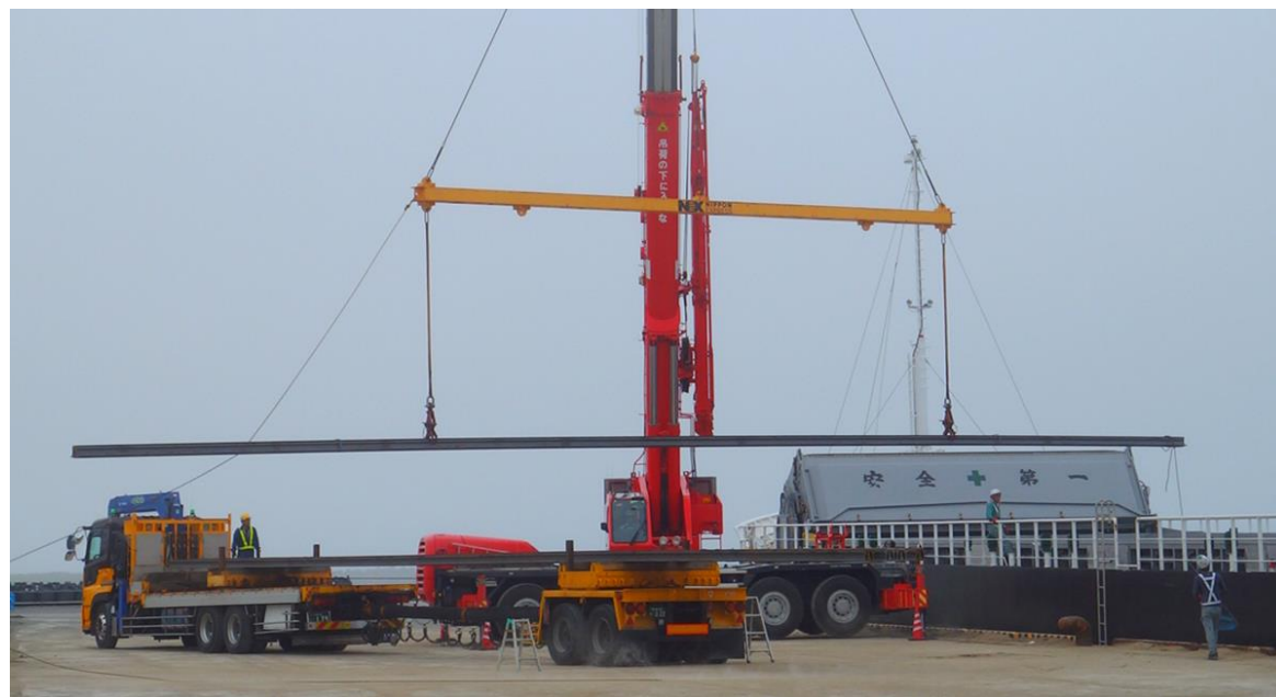
レール陸揚げの様子
