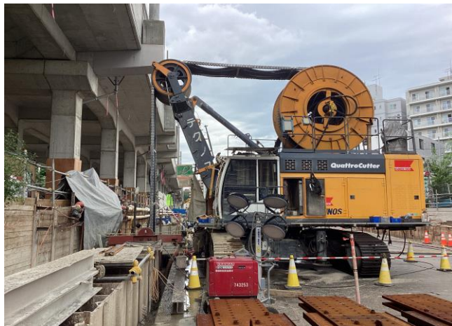
札幌トンネル(桑園) 鋼製連壁掘削状況
