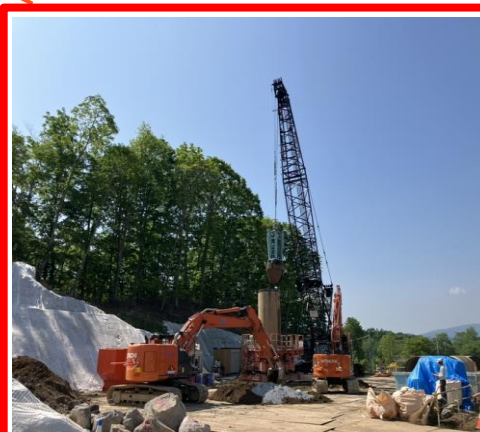
岩塊撤去状況
