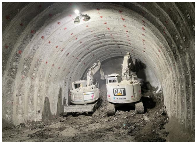
渡島トンネル(南鞆) トンネル掘削状況
