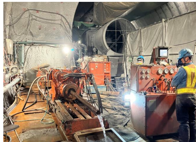
渡島トンネル(台場山) 長尺ボーリング実施状況
