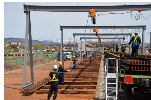
150mレールの貨車からの取り出し
