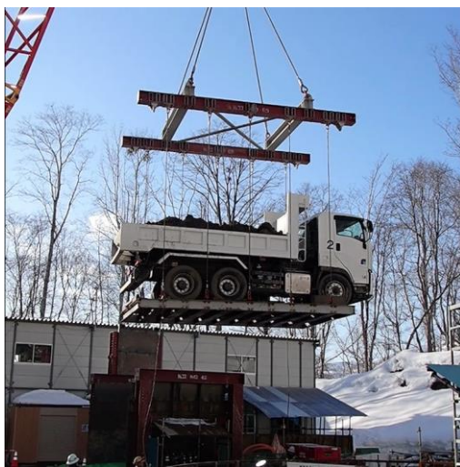
発生土搬出状況(到達立坑部(地上部))
