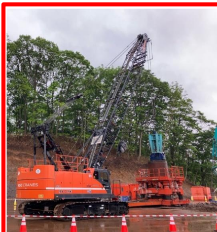
岩塊撤去状況
