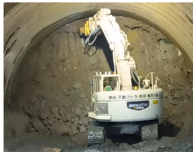
NATM掘削状況
