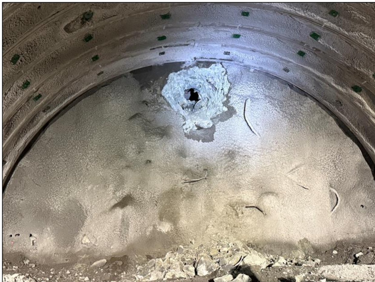
掘削完了地点の状況
