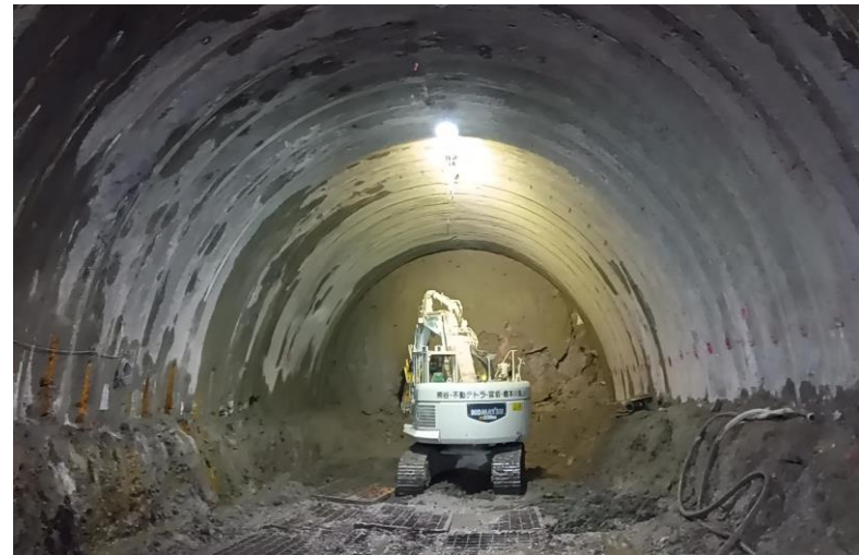
NATM掘削状況
