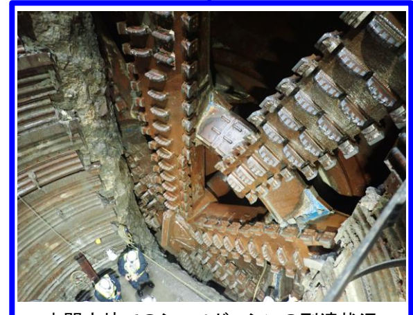
中間立坑でのシールドマシンの到達状況
