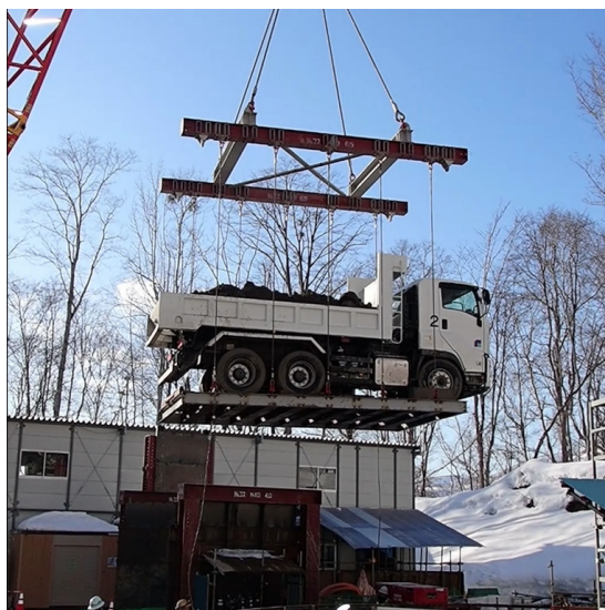
発生土搬出状況(到達立坑部(地上部))
