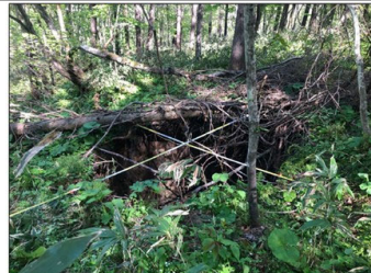
地表面陥没状況
