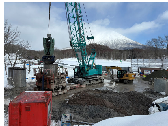
岩塊撤去状況
