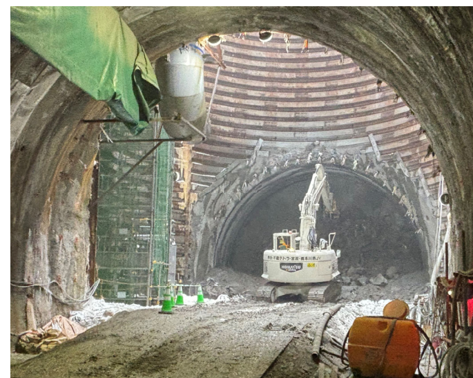
到達立坑からNATM掘削状況
