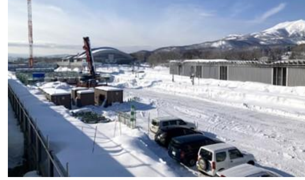
写真⑥ 倶知安駅高架橋(倶知安町)
