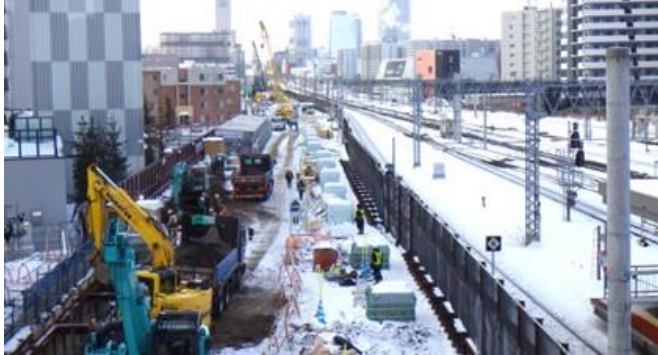
写真① 札幌車両基地高架橋(札幌市)
