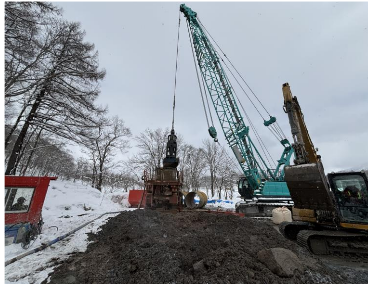
羊蹄トンネル(有島) マシン停止位置付近地上部岩塊撤去状況
