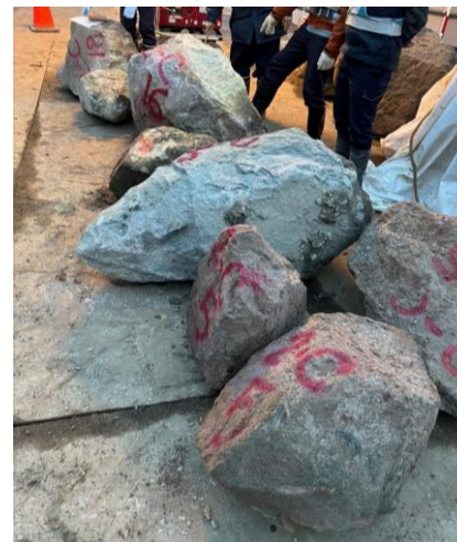
今回撤去した岩塊(長径最大約1.4m)
