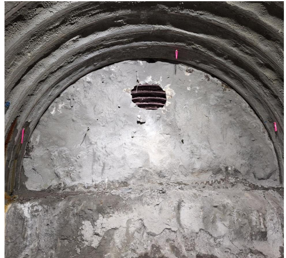
貫通点の状況
