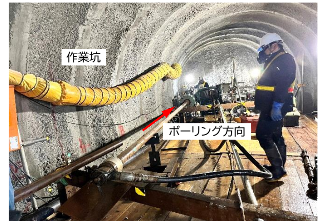
南鶉工区ボーリング削孔状況
