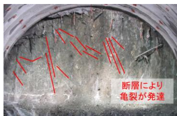
【特徴1】断層運動に伴う弱部の形成
