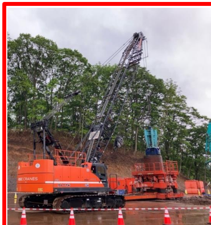
岩塊撤去状況
