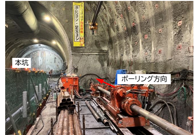
台場山工区ボーリング削孔状況
