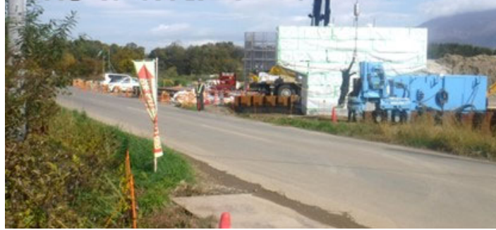
写真⑧ 宮田高架橋(里見工区)(二セコ町)
