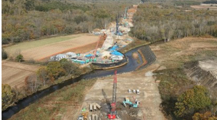
写真⑤ 琴平高架橋(倶知安町)
