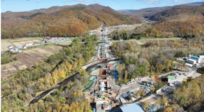
写真④ 明治高架橋(赤井川村)
