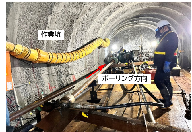
南鶉工区ボーリング削孔状況
