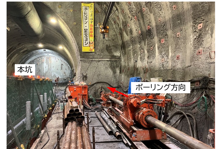
台場山工区ボーリング削孔状況
