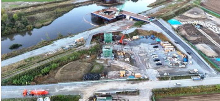
写真⑦ 岩尾別高架橋(倶知安町)
