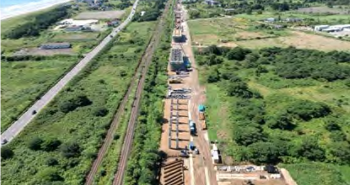
写真⑫ 平里高架橋(長万部町)
