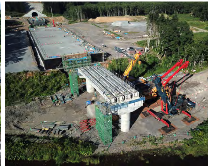
PCU形桁 架設状況
