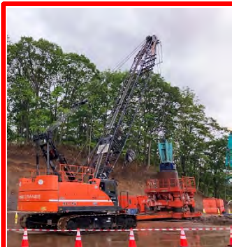
岩塊撤去状況
