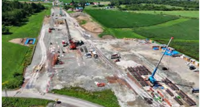
写真⑭ 新八雲(仮称)駅高架橋(八雲町)
