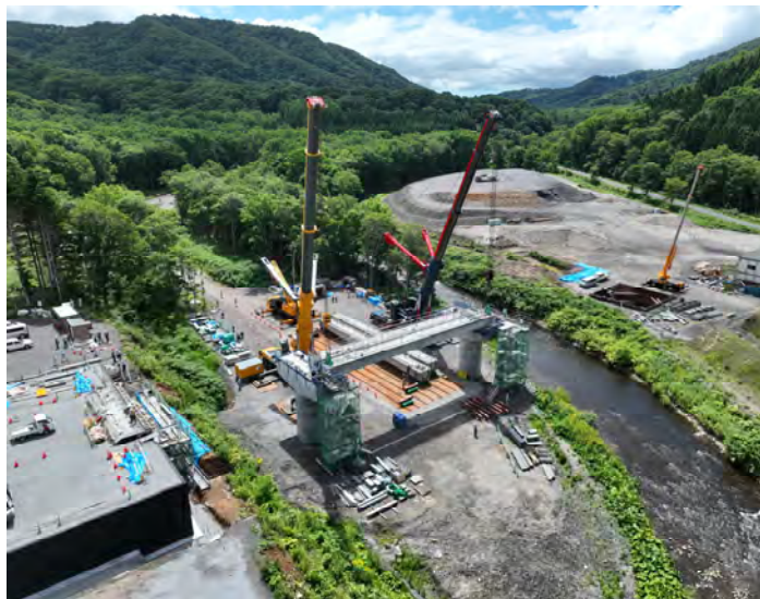
PCU形桁 架設状況
