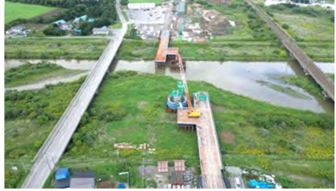
写真⑪ 栄原高架橋(長万部町)
