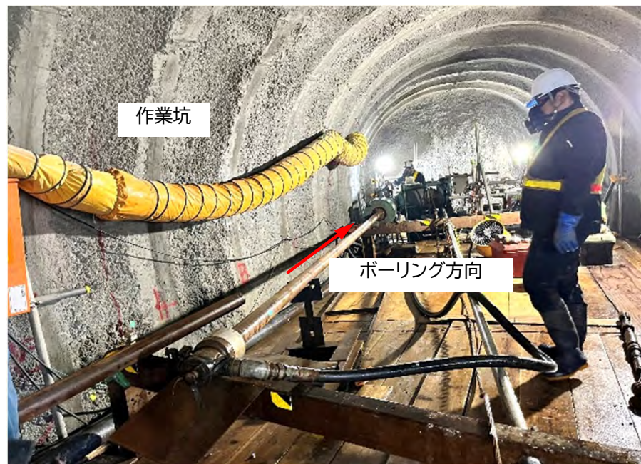
南鶉工区ボーリング削孔状況
