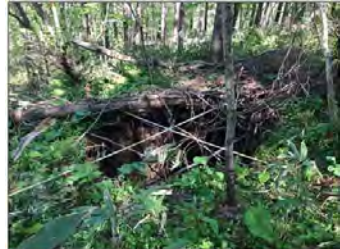
地表面陥没状況
