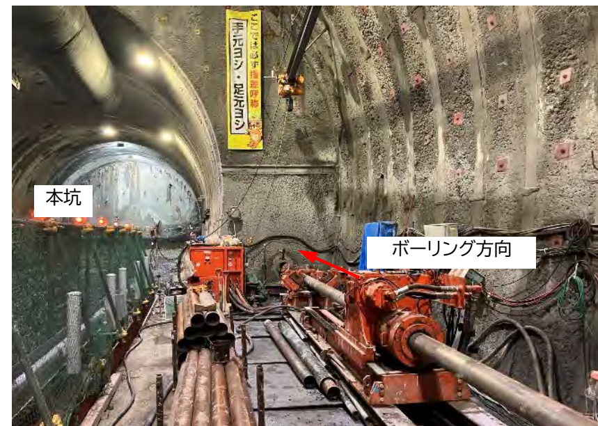
台場山工区ボーリング削孔状況
