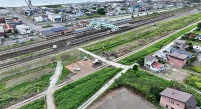
写真⑬ 長万部駅高架橋(長万部町)
