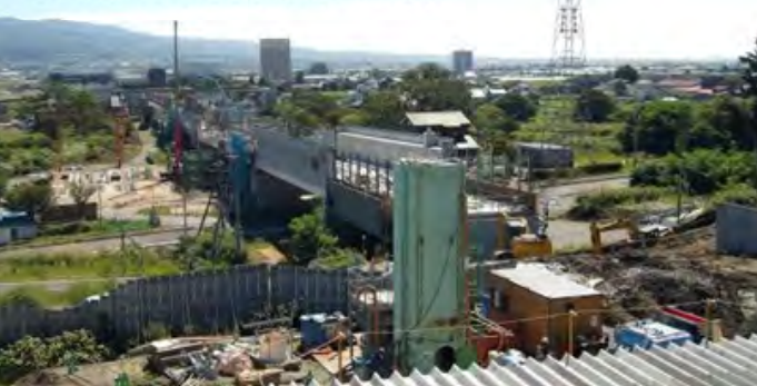
写真⑯ 市渡高架橋(北斗市)
