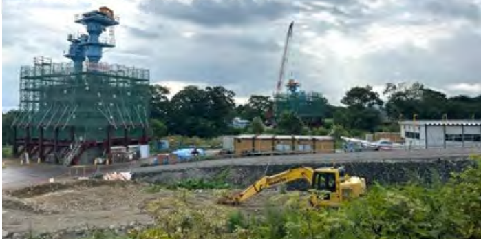
写真⑮ 大新高架橋(八雲町)
