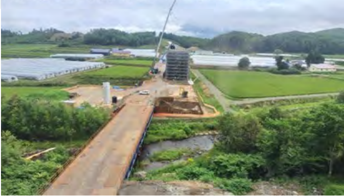
写真⑨ 宮田高架橋(宮田工区)(三ツ町)
