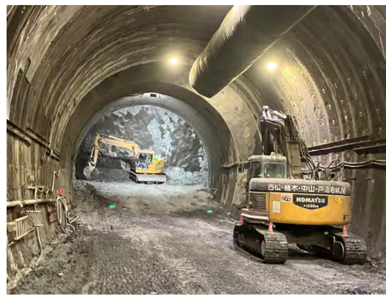
渡島トンネル(台場山) トンネル掘削状況
