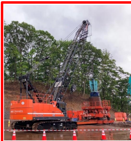
岩塊撤去状況
