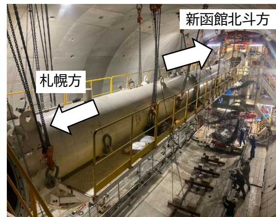
掘削を停止してシールドマシン後方設備組立ての様子
