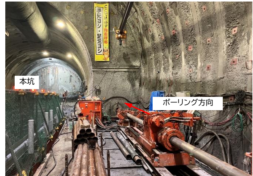
台場山工区ボーリング削孔状況
