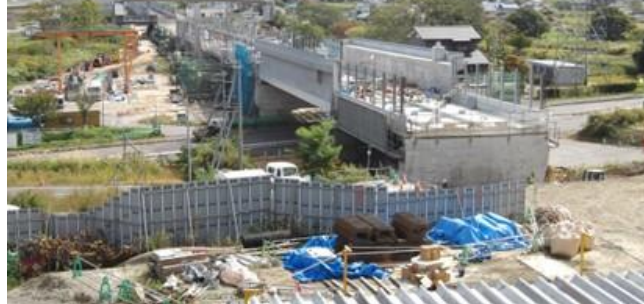
写真⑯ 市渡高架橋(北斗市)
