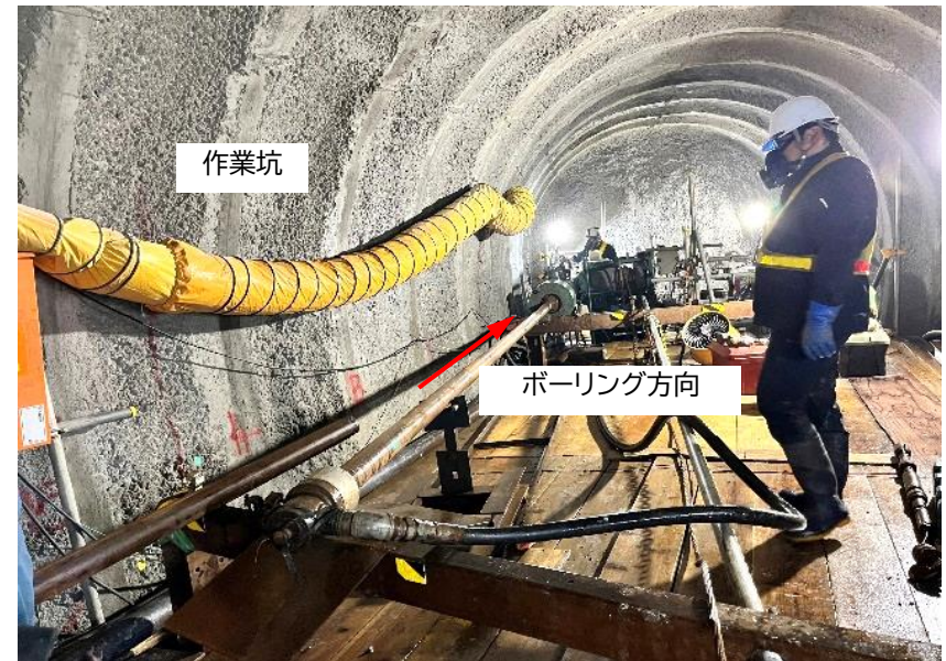
南鶉工区ボーリング削孔状況
