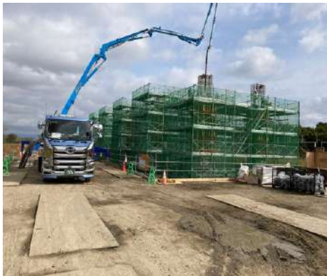
コンクリート打設状況
