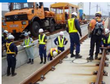
軌道の仕上がり状態等の確認
