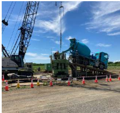
コンクリート打設状況
