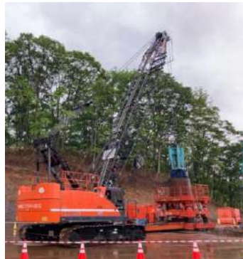
地上からの岩塊撤去状況
