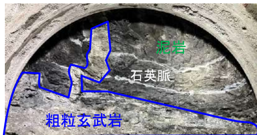
①165km071m 泥岩(八雲層)に粗粒玄武岩が貫入し、白い石英脈がある状況
