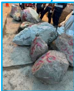
区間A①で撤去した岩塊
