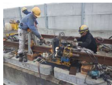
E : 二次溶接
