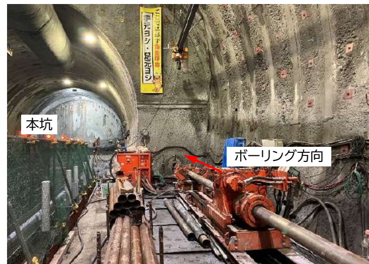
長尺ボーリング削孔状況
