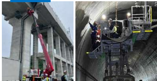
構造物の仕上がり状態、所要寸法等の確認
