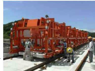
D : 軌道スラブ敷設
