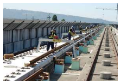
D : レール敷設
