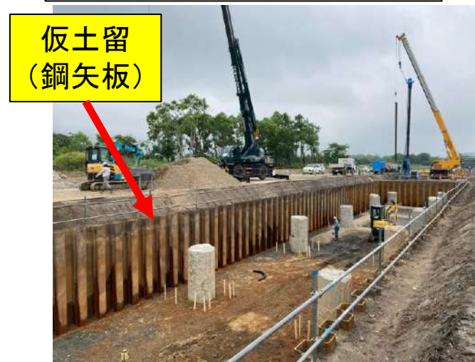
仮土留(鋼矢板)設置状況
