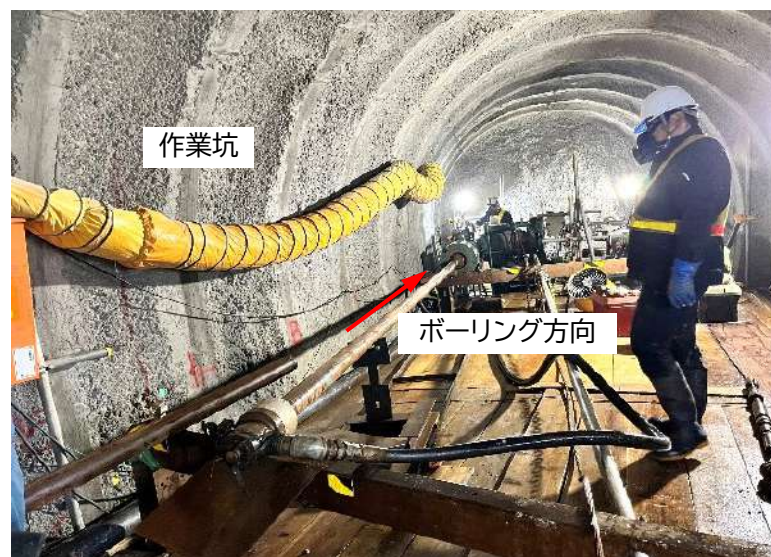
長尺ボーリング削孔状況
