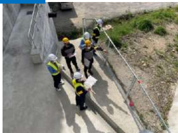
用地杭、用地侵害防除柵の設置状況等の確認
