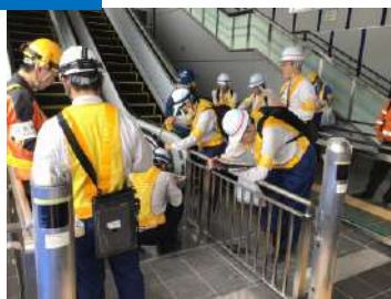
機械設備の外観検査及び機能確認等
