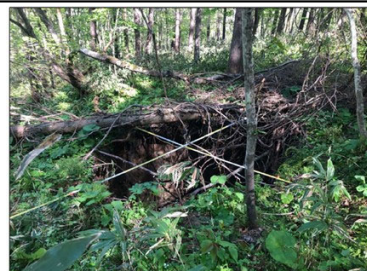
地表面陥没状況
