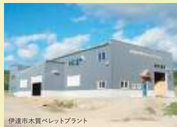
伊達市木質ペレットプラント
